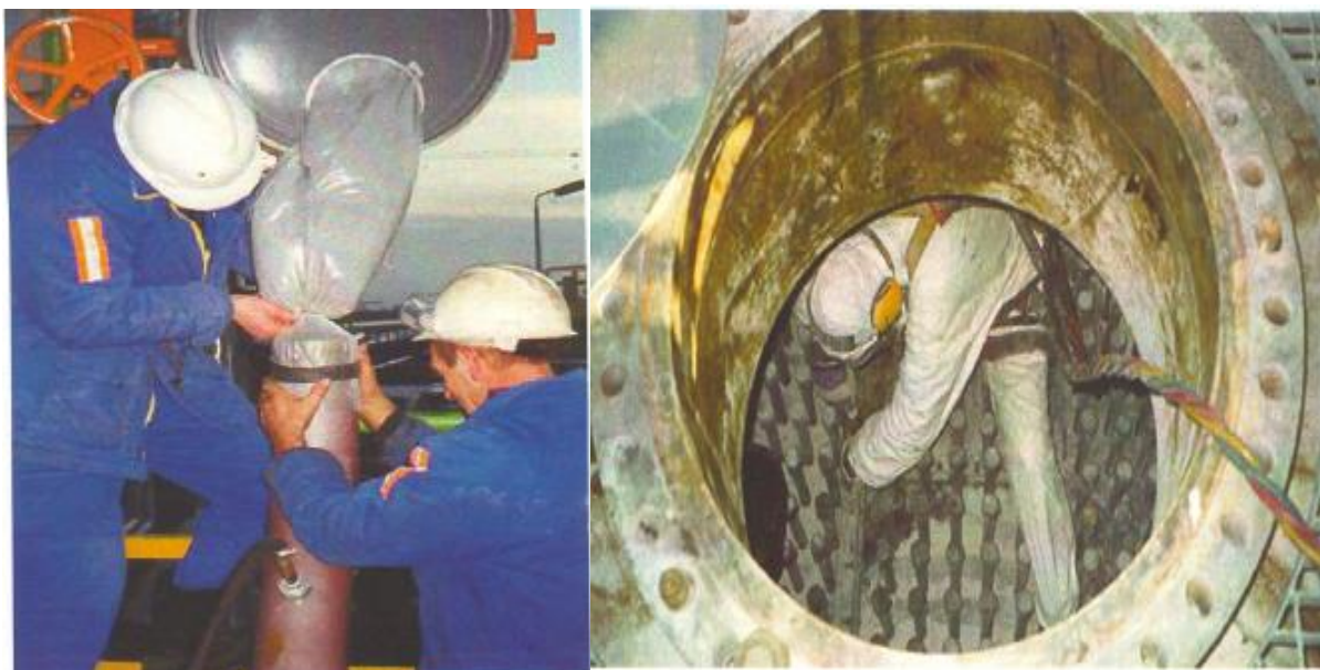
Рисунок 3.8 – Окончательная загрузка катализатора
