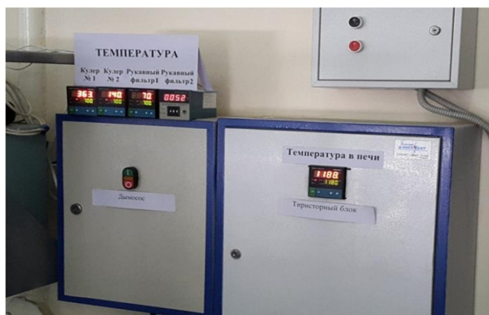
Рисунок 5.8 – Тиристорный блок с терморегуляторами
