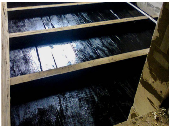
Сурет 7 а -Битум лакпен боялған ағаш конструкциялар
