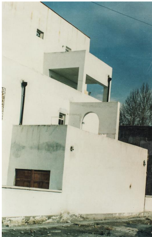
Рис. 6. Жилой дом в г. Коканде.
