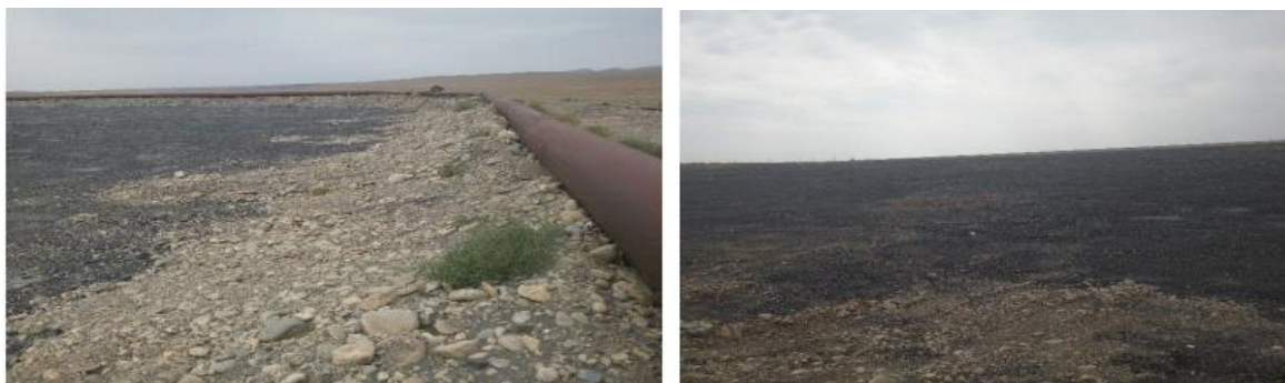
Рис. 1 – Хвостохранилище отходов обогащения полиметаллических руд АО «Ачполиметалл» в г. Кентау
