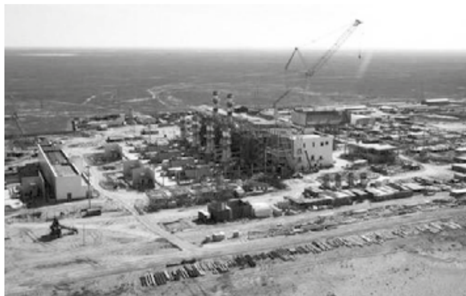
Газ-турбиналық станция құрылысы алаңының көрінісі «Karabatan Utility Solutions» ЖШС
