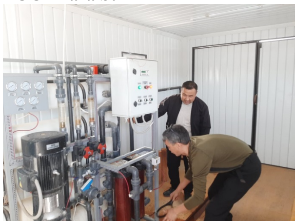
Рисунок 17-18 Процесс регенерации мембраной установки, село Дастан Сарыагашский район
